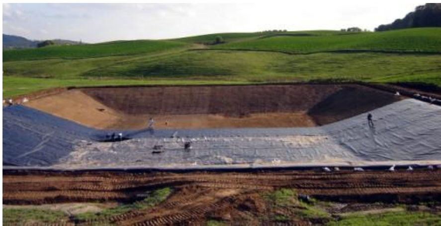
Рисунок 20. Укладка геомембраны в лагуне
