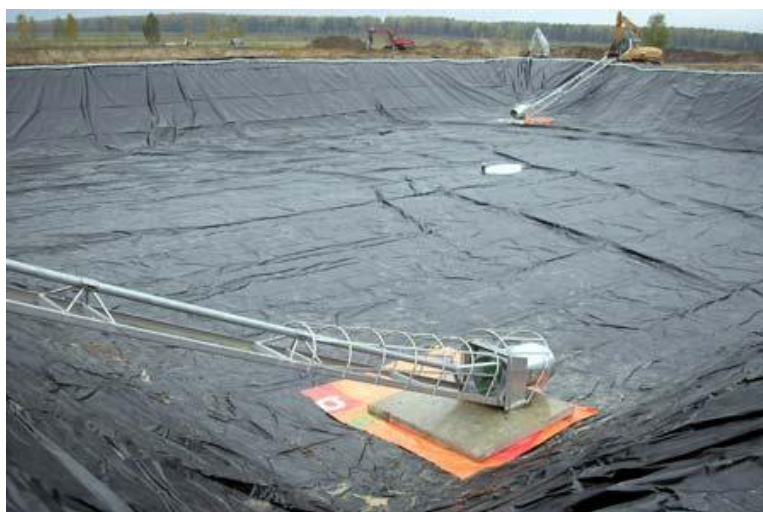
Рисунок 21. Установка оборудования в лагуну
