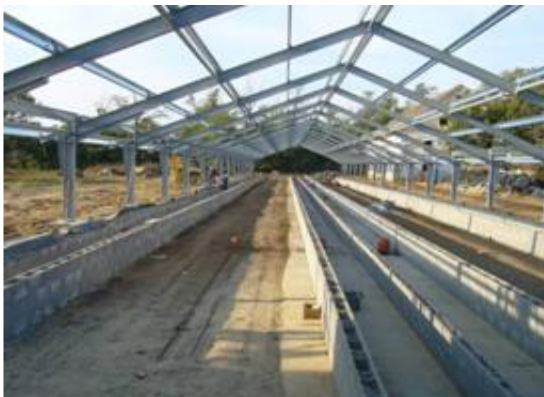
Рисунок 13. Несущая конструкция отделения откорма
