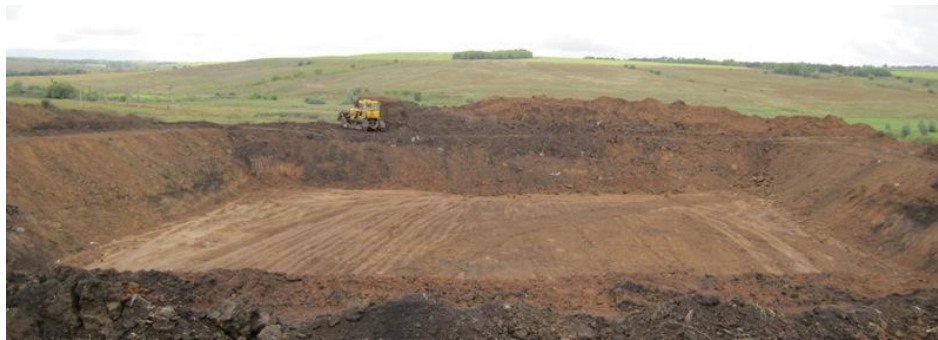
Рисунок 19. Подготовка котлована для лагуны
