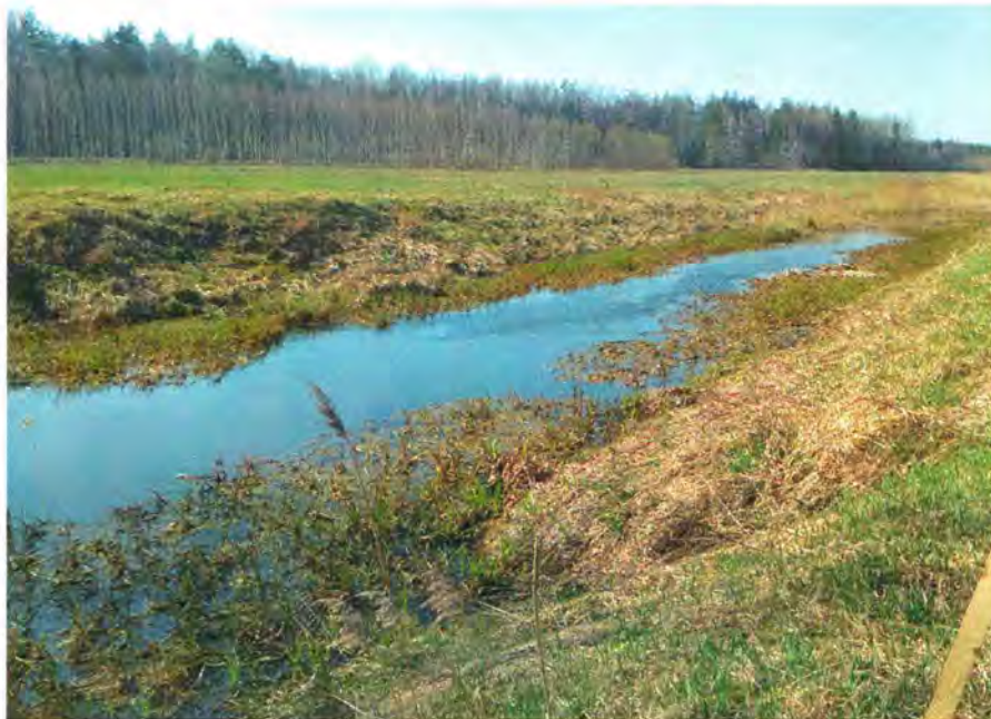
Рис. 4.6 Канал – приемник очищенных сточных вод (апрель 2019г.)
